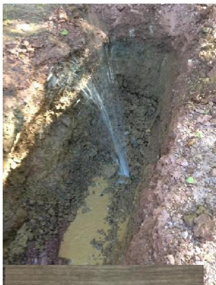
Une énorme fuite d'eau a été détectée dans les canalisations entre le réservoir et la rue de la forêt.
